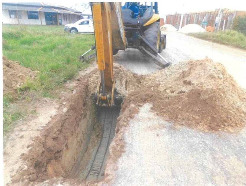
Foto 01. Escavação no ponto A
