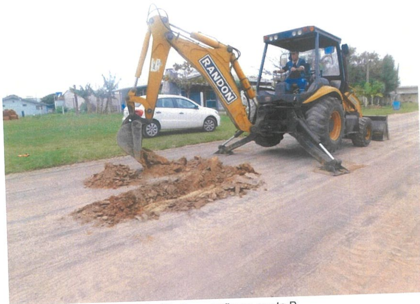
Foto 03. Escavação no ponto B.
